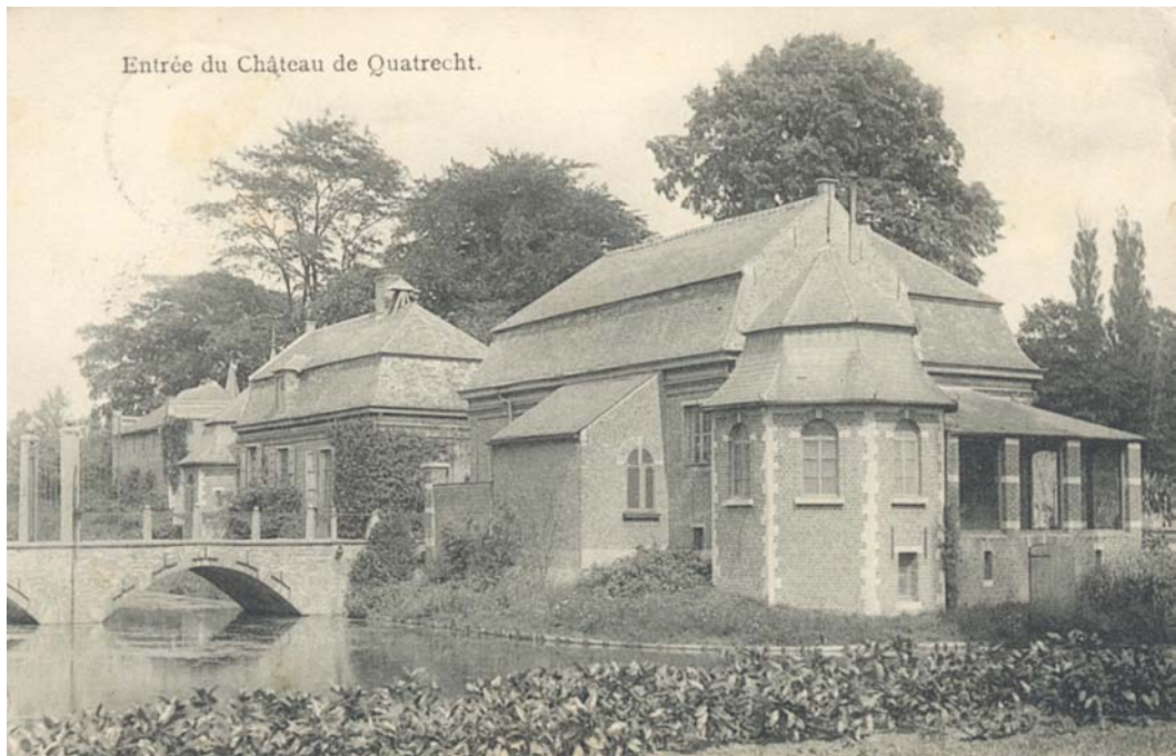
Entrée du Château de Quatrecht
