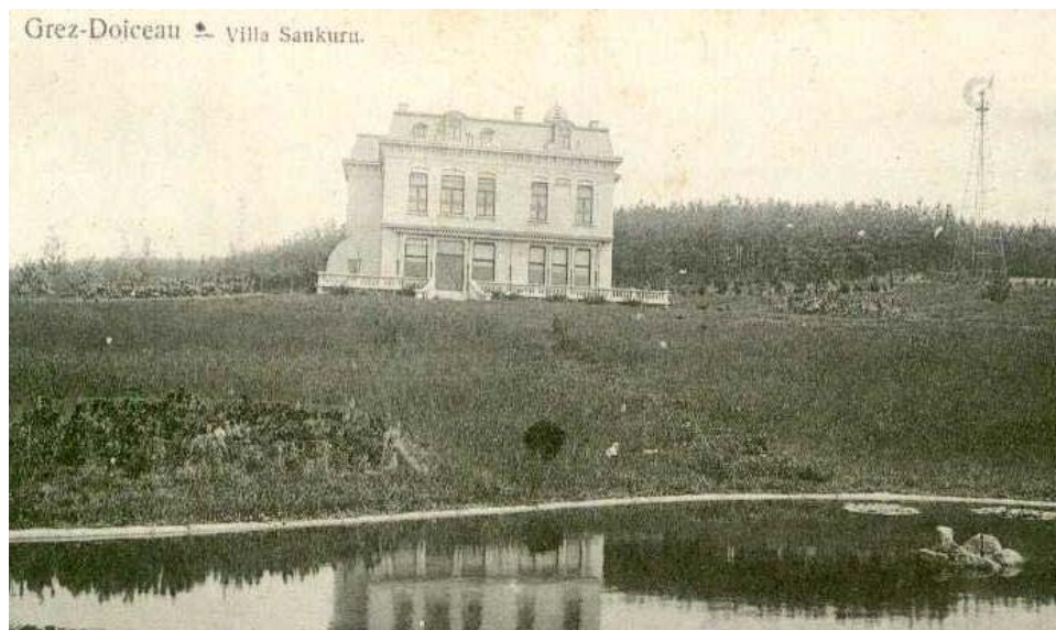
La villa Sankuru avec l'étang et l'éolienne.
